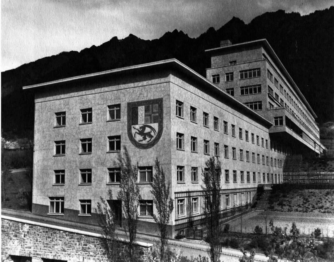
Ursprungsgebäude 1937 – 41 (Architekten C. Brun und R. Gaberel)
