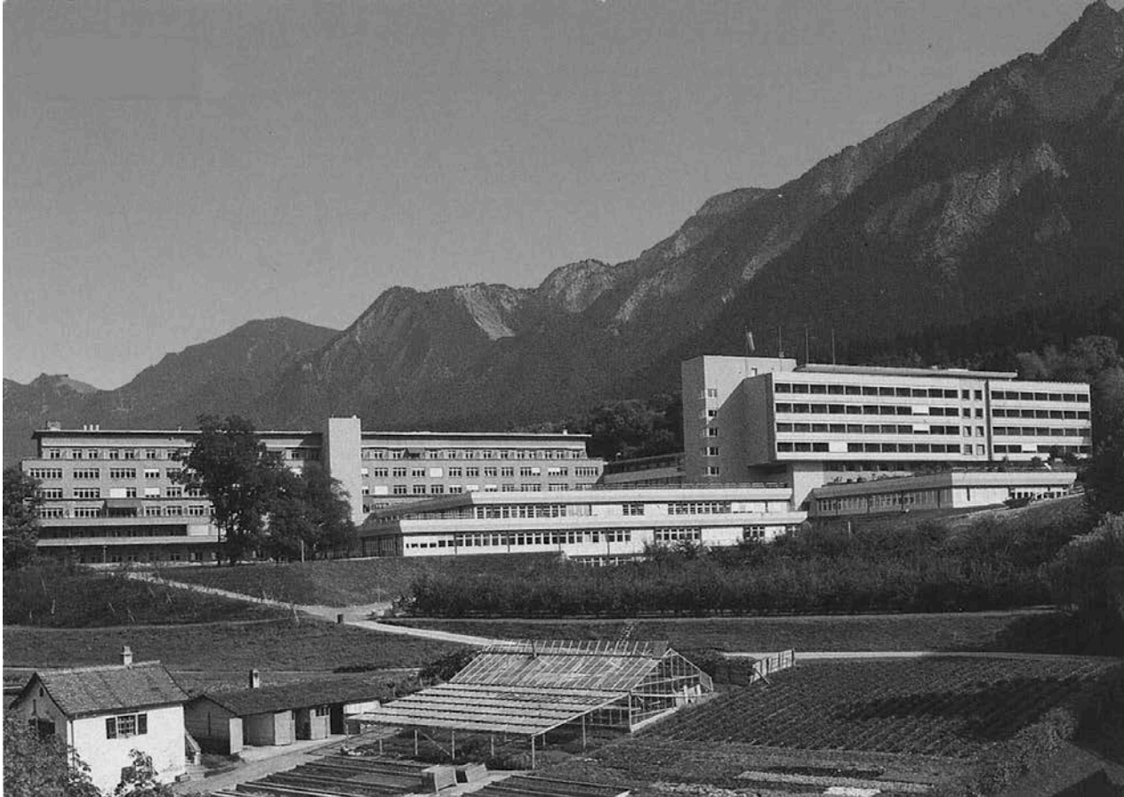
Erweiterungsbauten 1966 (Haus C) und 1984 (Haus B)
